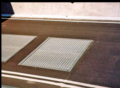
Nedkørsel til Roskilde P-hus
